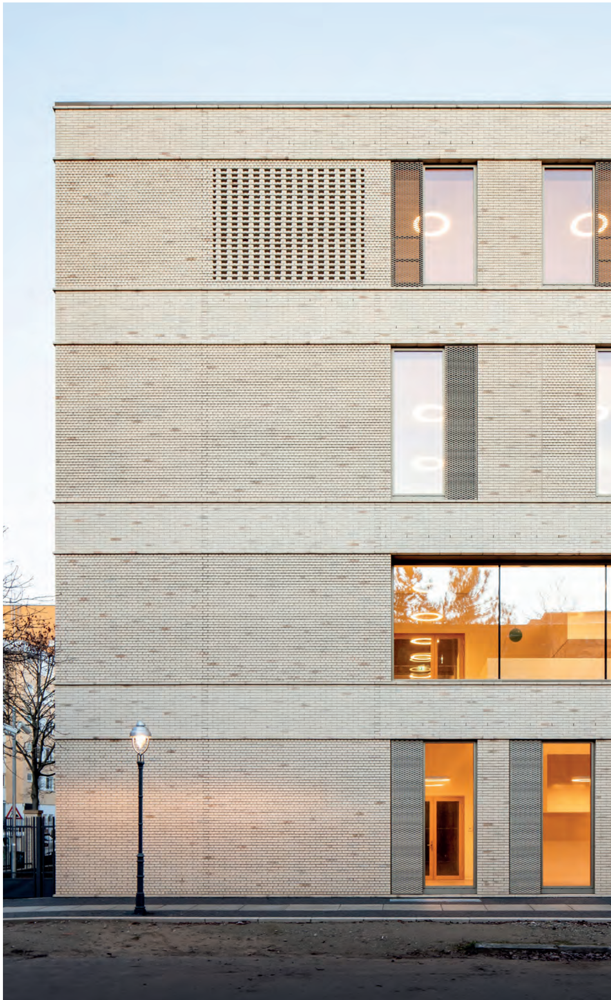
Foto: Koy + Winkel | Rohdecan Architekten GmbH, Dresden | Walther-Meißner-Bau, Berlin
