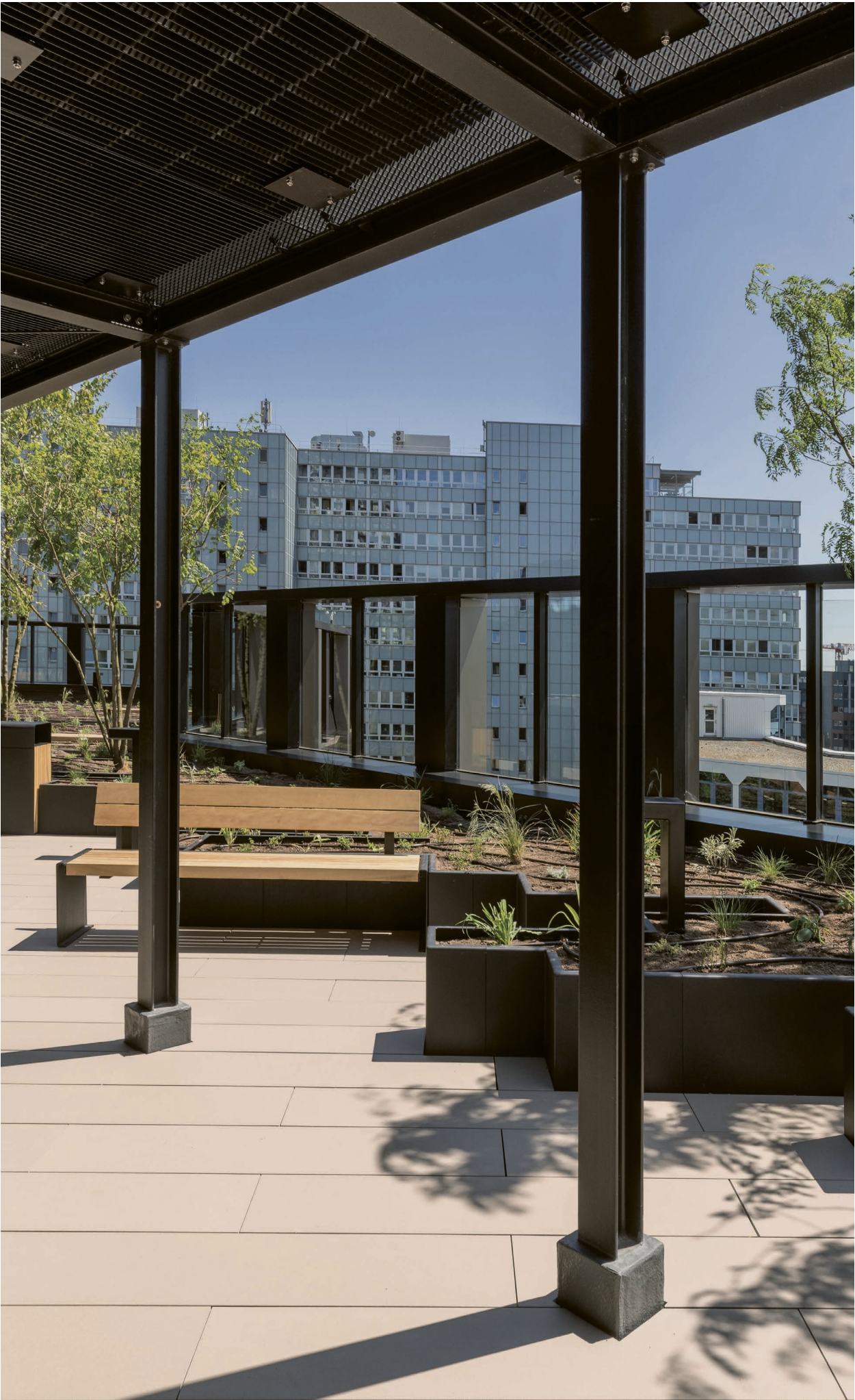
Dachterrasse, Das Mergenthaler | Foto: WÖHR + BAUER GmbH
