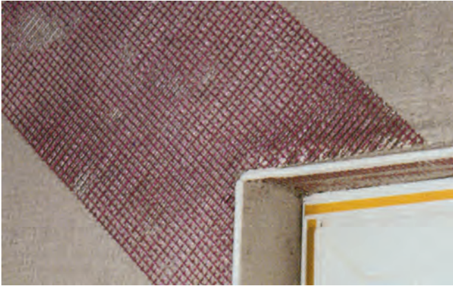
Bild 7: Armierungspfeil an Öffnungsecken
