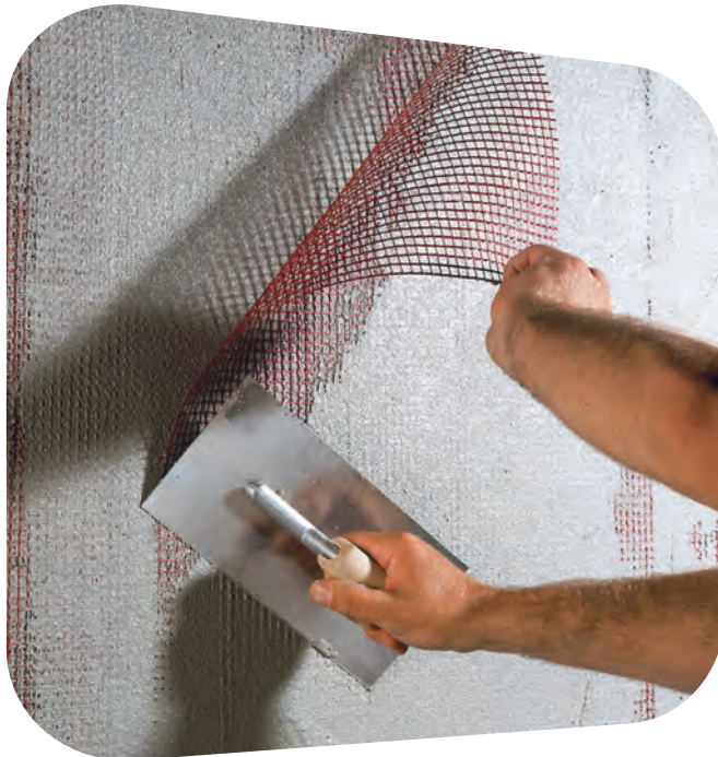
Bild 8: Armierungsputz mit Gewebeeinlage
